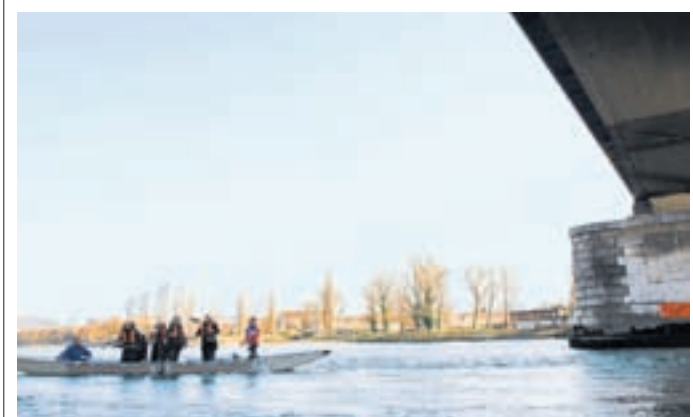
Grundstein gelegt. Zürich will für eine zweite Basler Bahnbrücke lobbyieren – doch diese ist bereits im Bau. Foto H. Muchenberger
